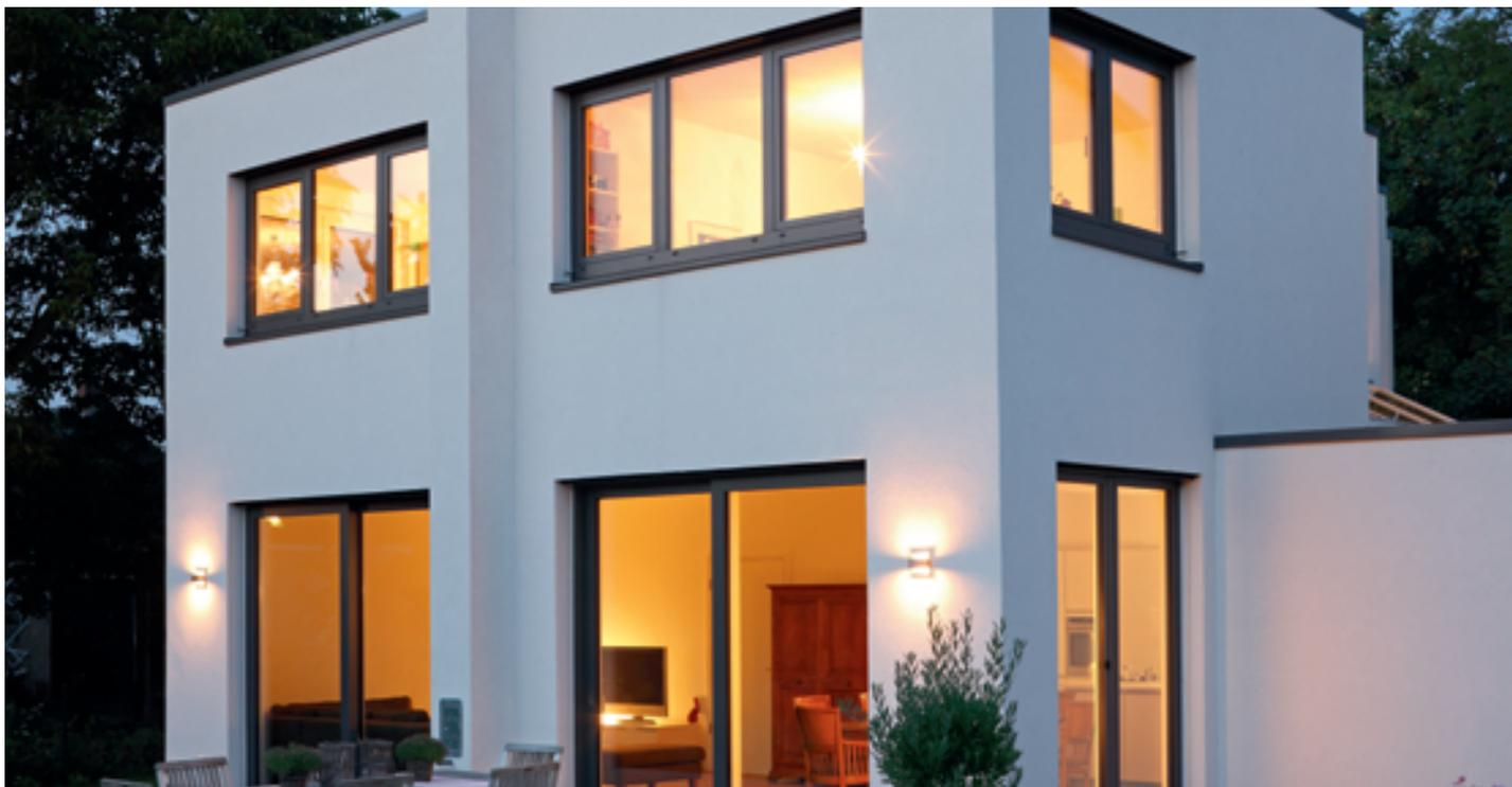
Ahorrar energía sin compromisos: El sistema de ventanas Schüco AWS 75.SI (Super Insulation) con un alto aislamiento térmico establece, con un valor medio  $U_f$  de  $1,4 \text{ W/m}^2\text{K}$ , un nuevo estándar en aislamientos térmicos para ventanas de aluminio sin mermar en confort o diseño. Los perfiles finos aseguran un máximo de transparencia proporcionándole a su hogar estancias llenas de luz.
